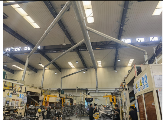
焊接区废气收集管道
