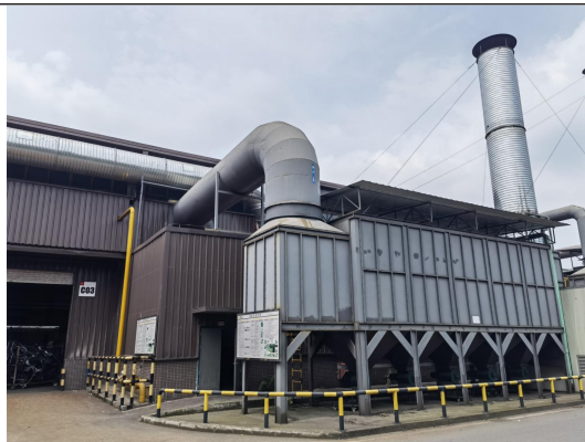
滤筒除尘器及排气筒（2#）
