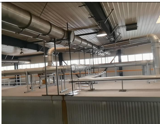
喷塑、电泳废气收集管道
