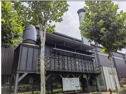
滤筒除尘器及排气筒（1#）
