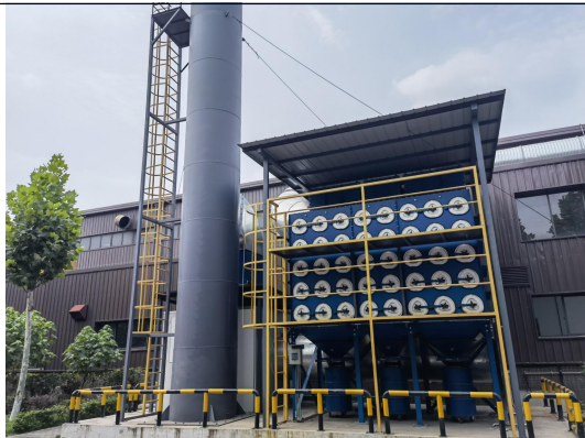
滤筒除尘器及排气筒（3#）
