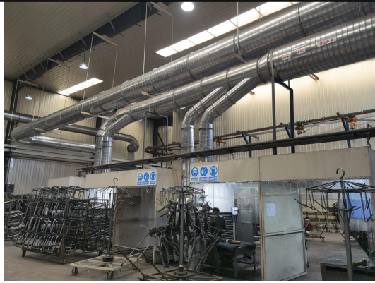
打磨工位集气罩及管道
