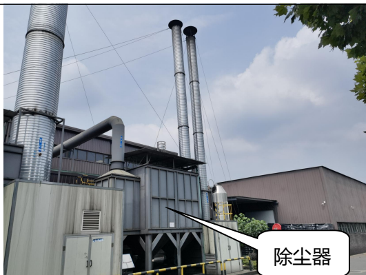
抛丸废气除尘器及排气筒（4#）
